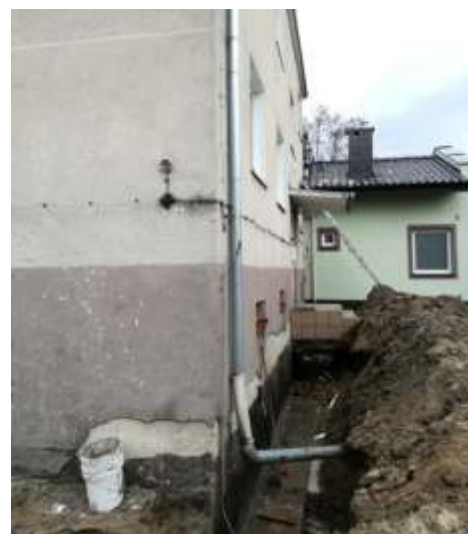
Na zdjęciu: prace termomodernizacyjne obiektu w miejscowości Cedry Wielkie
