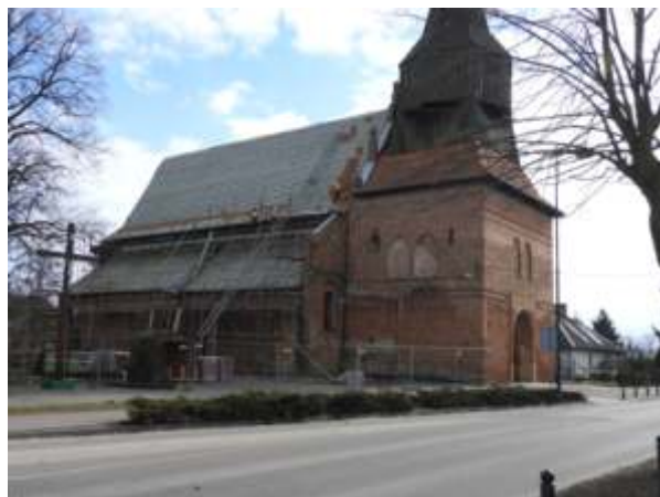
Na zdjęciu: Prace budowlano - remontowe Kościoła w Cedrach Wielkich
