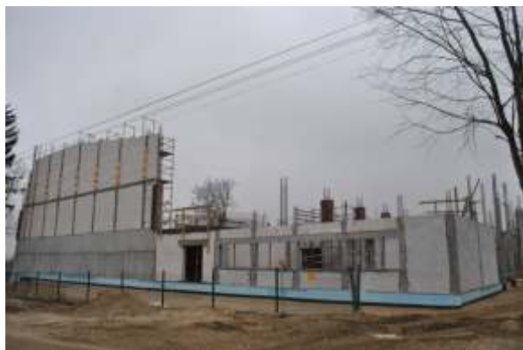
Na zdjęciu: Postępujące prace budowlane hali
