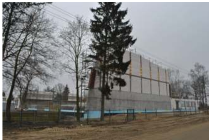
Na zdjęciu: Postępujące prace budowlane hali
