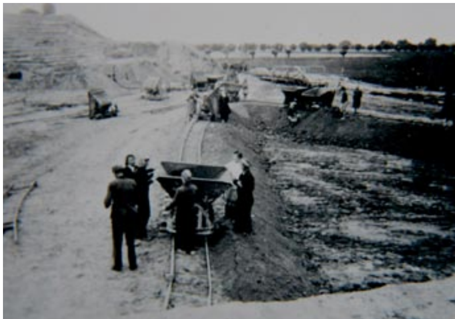
Odbudowa wału przeciwpowodziowego w okolicach Kieźmarka w 1945 roku
