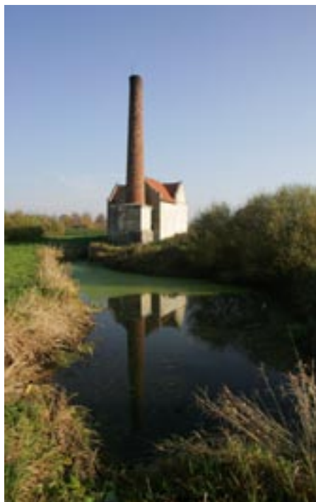
Budynek pompy parowej w Rózanach
