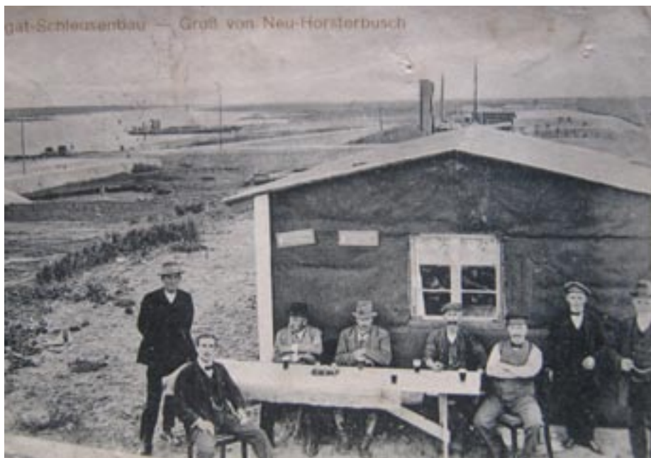
Pracownicy na budowie śluzy na Nogacie
