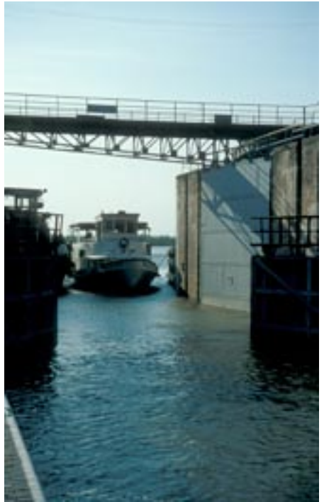
Wrota przeciwpowodziowe na Gdańskiej Głowie
