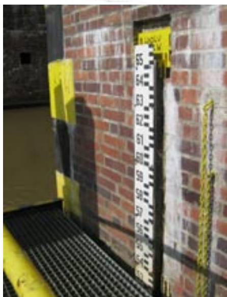
Łata pomiarowa wodowskazu na Gdańskiej Głowie
