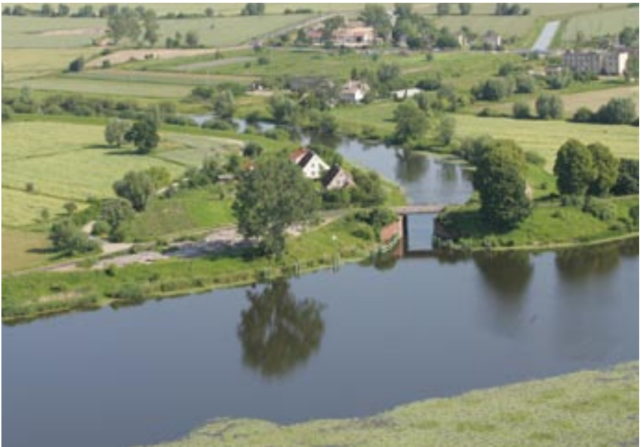
Wrota przeciwpowodziowe na Kanale Jagiellońskim
