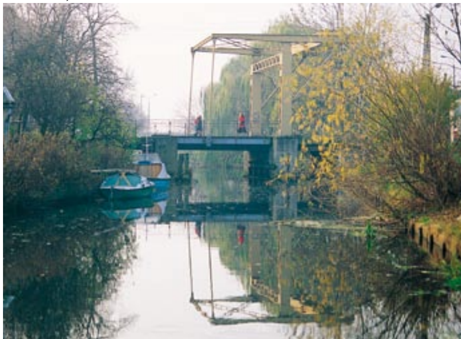
Most zwodzony w Nowym Dworze Gdańskim
