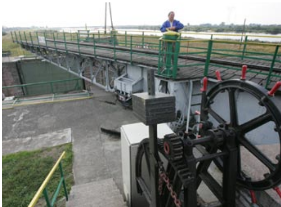
Most obrotowy na Gdańskiej Głowie
