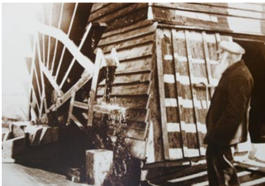
Koło czerpakowe wiatraka odwadniającego
