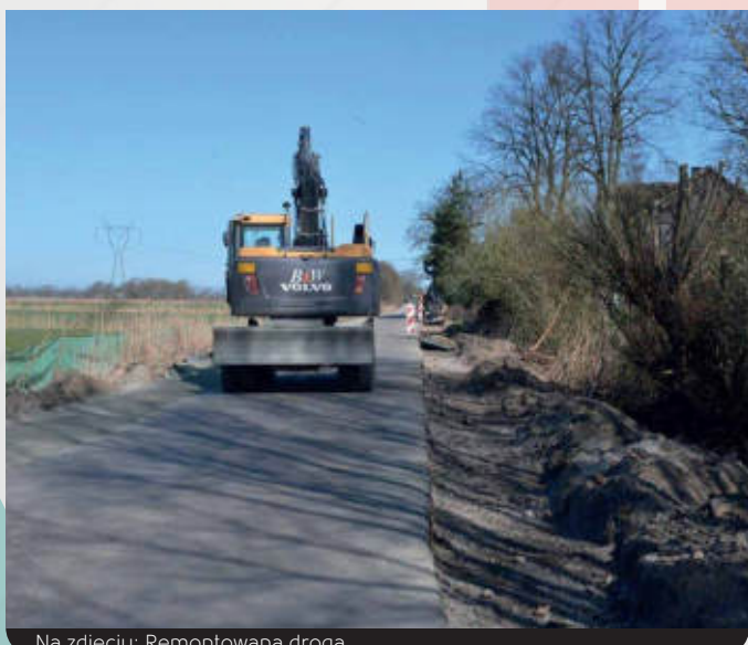
Na zdjęciu: Remontowana droga.
