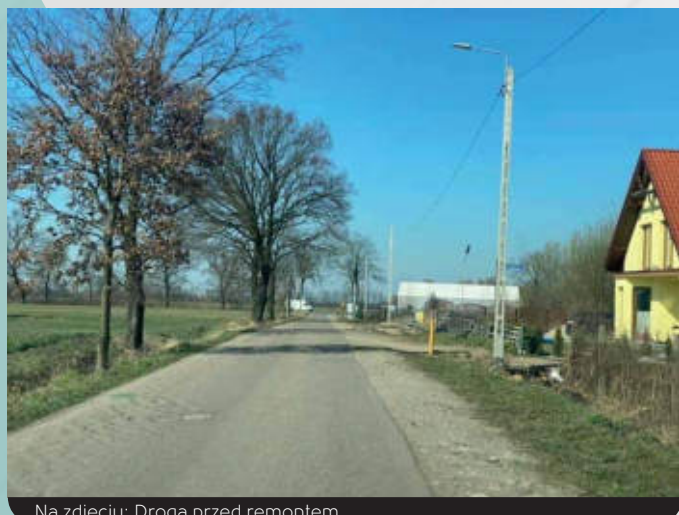
Na zdjęciu: Droga przed remontem.
