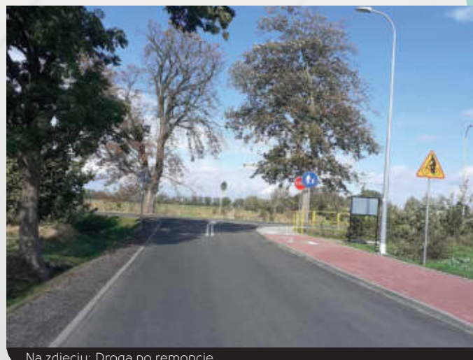
Na zdjęciu: Droga po remoncie.
