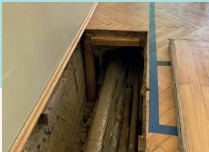
Na zdjęciu: Fragment wymienianej instalacji wodociągowej.
