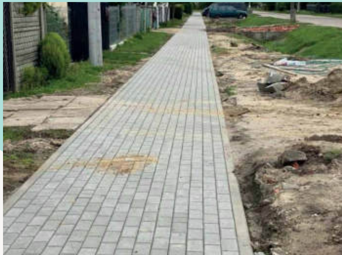
Na zdjęciu: Remontowany odcinek chodnika.
