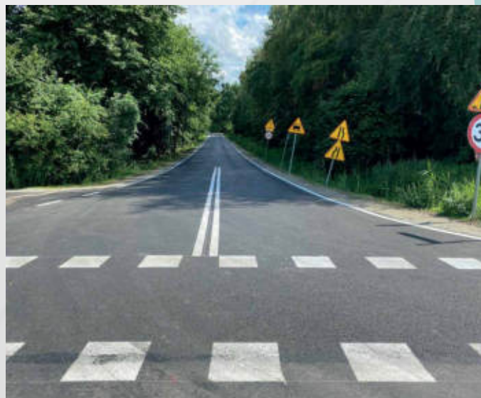
Na zdjęciu: Wyremontowany odcinek drogi.
