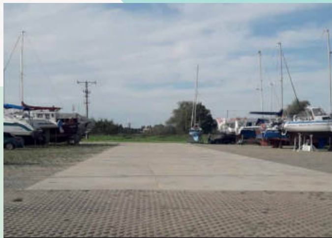
Na zdjęciach: Utwardzony teren przystani w Błotniku.
