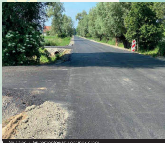
Na zdjęciu: Wyremontowany odcinek drogi.
