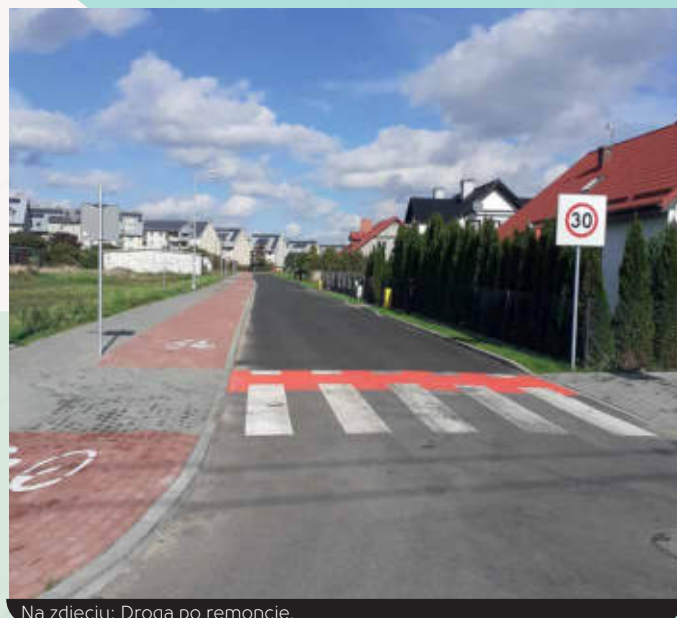
Na zdjęciu: Droga po remoncie.
