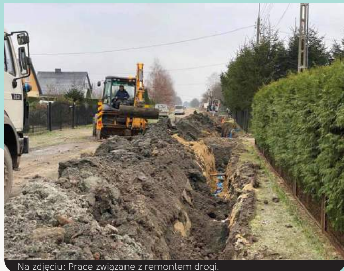
Na zdjęciu: Prace związane z remontem drogi.
