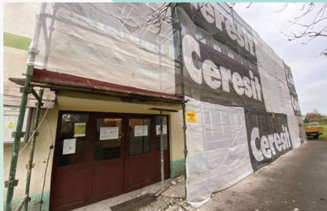
Na zdjęciu: Prace związane z remontem budynku Gminnej Spółdzielni.
