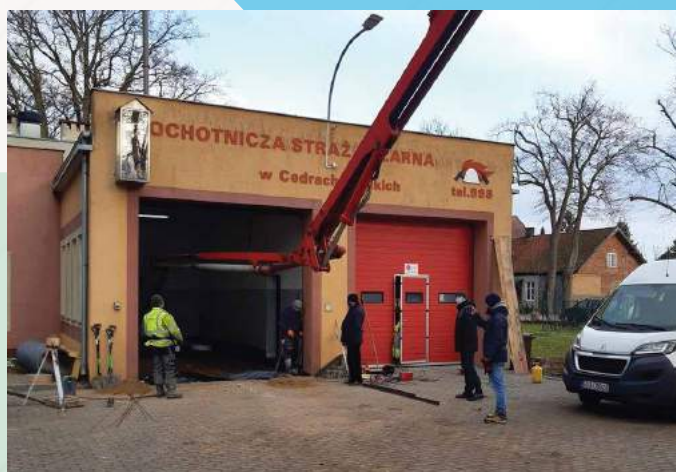
Na zdjęciu: Prace związane z remontem posadzki.
