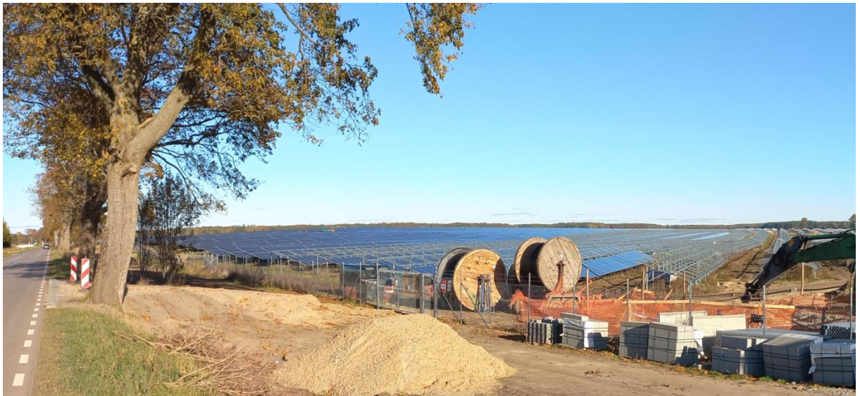
Fot. 1. Oddziaływanie dużego zespołu ogniw fotowoltaicznych (w budowie) na krajobraz równinny.
