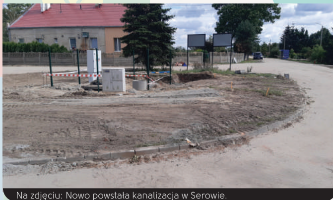
Na zdjęciu: Nowo powstała kanalizacja w Serowie.
