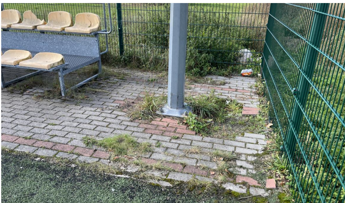
Fot. Fragment nawierzchni do przełożenia i uzupełnienia.
