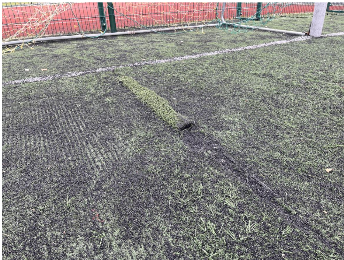
Fot. Istniejąca trawa syntetyczna do wymiany.
